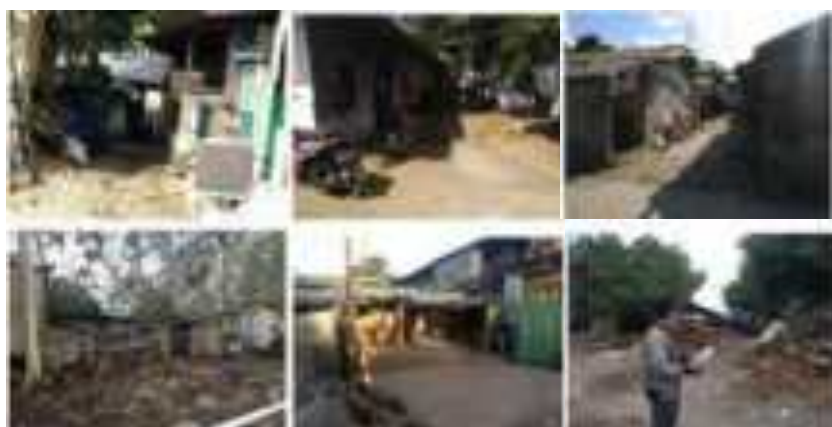
Gambar III.43 Kondisi Perumahan Berpotensi Kumuh di Kecamatan Kuta Selatan
